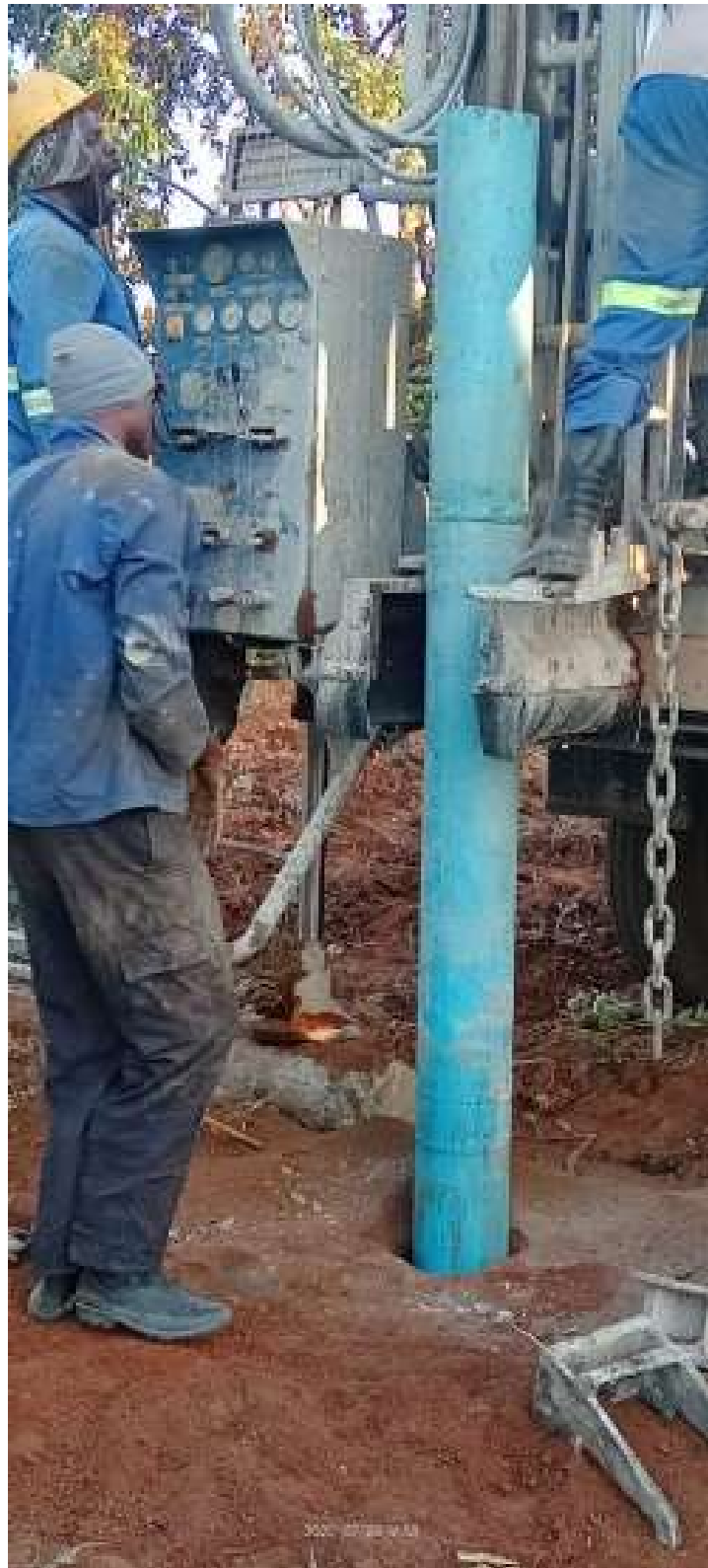
Bohren des Brunnens in Gomonda
